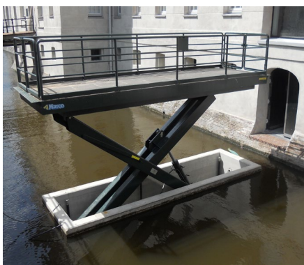
Hubtisch in Grube eingebaut
