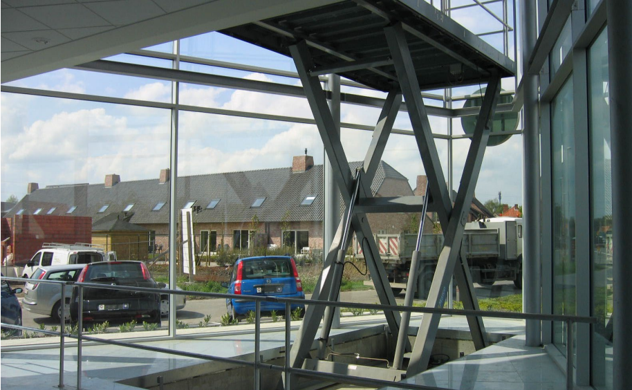
Grubeneinbau mit Geländern als Schutzeinrichtung
